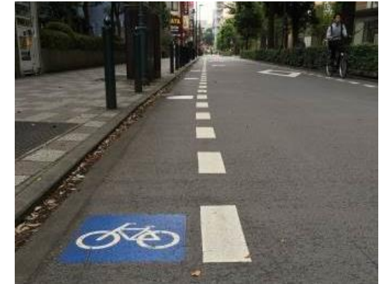
路線名：市道第16号線（かたらいの道） 整備手法：法定外表示 自転車誘導レーン（武蔵野方式）
