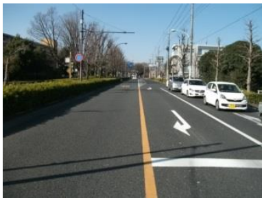
井の頭通り (都道武蔵境通り・交差部西)
