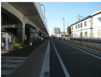
市道第310号線 (武蔵境駅西高架下駐輪場付近)
