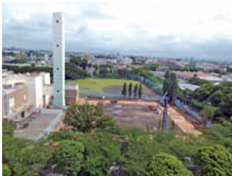
工事着手 平成26年5月
