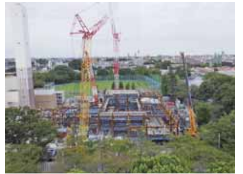
地上工事 27年8月～
