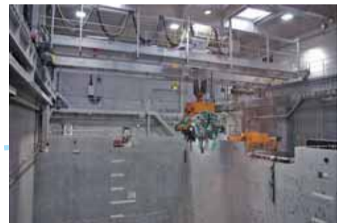
可燃ごみピット
