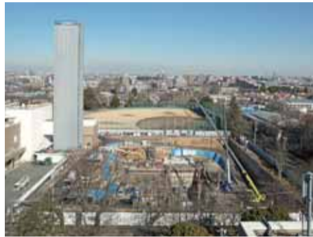
地下工事 27年1月～
