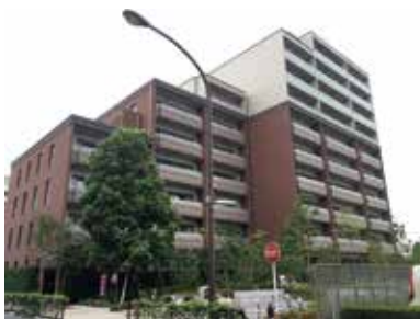
高層部の色彩を高明度にする事で、軽さを演出した集合住宅の例
