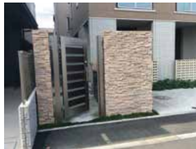
ごみ箱の前に扉をつけて通りから見えないようにした集合住宅の例
