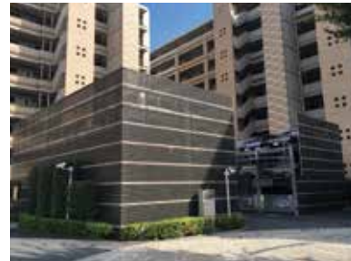
敷地内の立体駐車場をルーバー壁と植栽で囲んだ集合住宅の例
