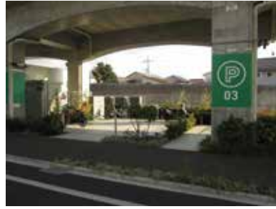
高架下にある駐輪場の周囲を緑化した例
