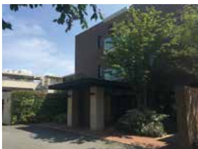
エントランスの横にシンボルツリー を配置した集合住宅の例
