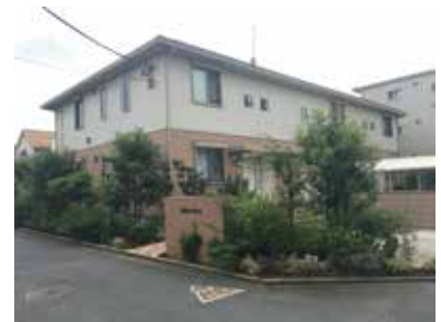
角地の部分を中心に接道部を緑化 した集合住宅の例
