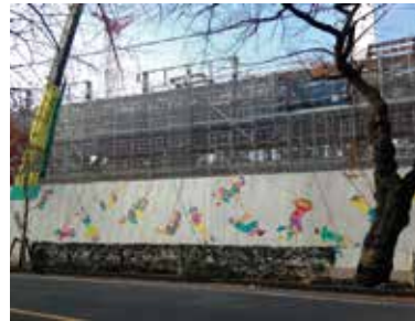
市内の小学生が参加して作成した 武蔵野クリーンセンター（工事中）の仮囲いの例
