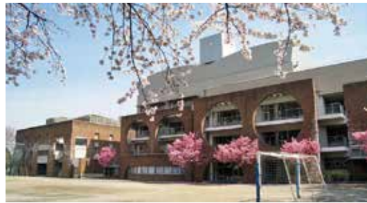
外壁に素材感のある材料を用いた千川小学校の例
