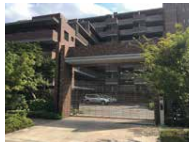
駐車場の入口を建築物と一体的にデザインした集合住宅の例
