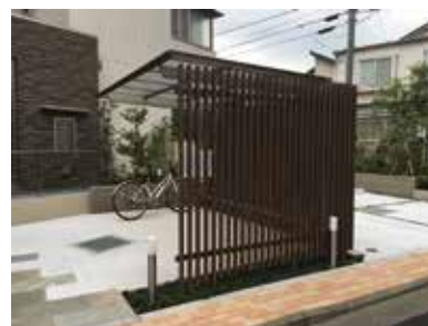
駐輪スペースをルーバーで目隠しし足元や周囲を緑化した集合住宅の例
