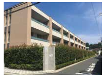
バルコニーの物干しを手摺の内側に設置して外から見えにくくした集合住宅の例
