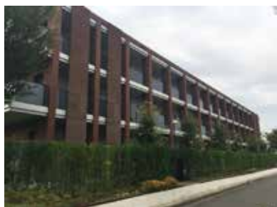
壁面を分節化することで圧迫感を和らげている有料老人ホームの例
