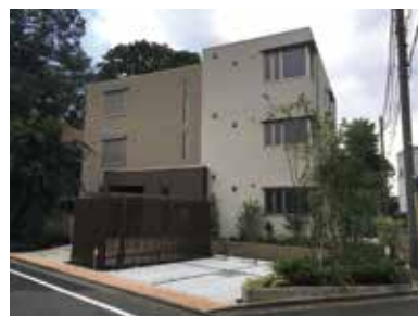
外壁面の色彩を分節化し、圧迫感を和らげている集合住宅の例
