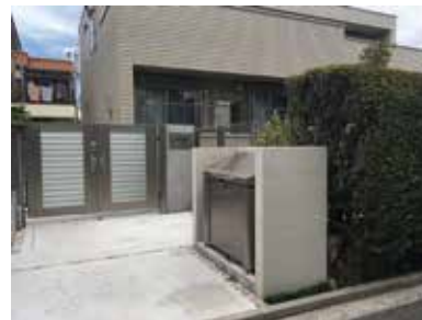
ごみ箱が目立たないように側壁を付けた集合住宅の例
