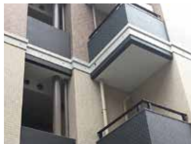
配管の色彩を建築物の壁面と同系色に塗った集合住宅の例（神戸市）
