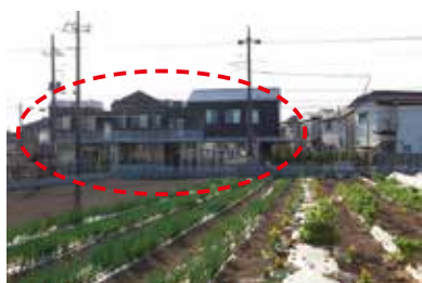
形態の変化により建築物を分節化した八幡町コミュニティセンターの例
