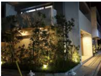
植栽を照明で演出した集合住宅の例
