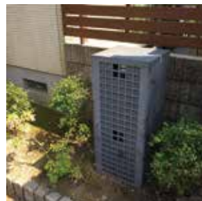
ガスメーターをボックスに入れて目立たないように配慮している例
