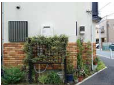
給湯器の配線やガスメーターを植栽で目隠した例
