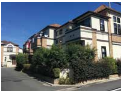
道路側から壁面を十分に後退させた例
