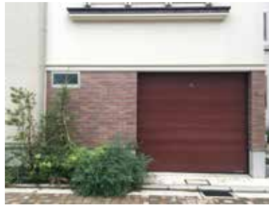
駐車スペースの扉を外壁と調和した木目調とし、景観に配慮した例
