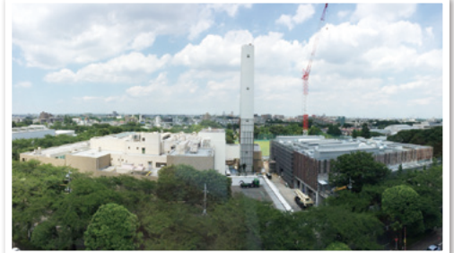
写真左が現クリーンセンター、右が新クリーンセンター。
