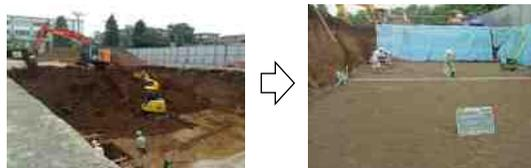
② 透水性シートの上に、プラスチック製の製品を並べて貯留槽をつくり透水性のシートで覆います。
