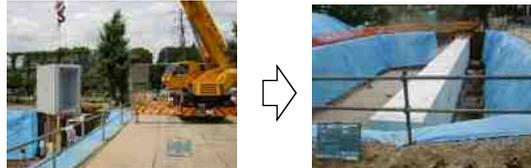
④ 貯留浸透施設へ雨水を引き込む下水道管や人孔を設置します。
