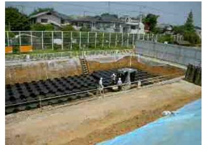
貯留浸透施設の設置工事の様子
