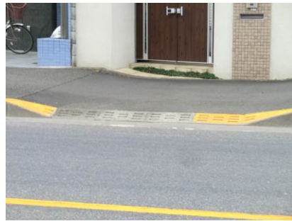
写真5 井の頭通りの歩道の切 り下げ
