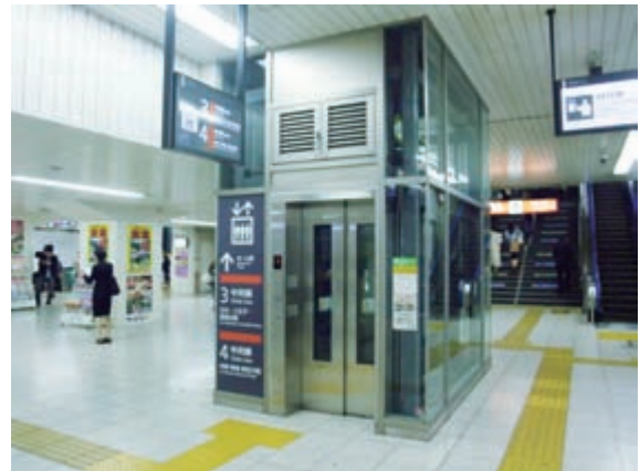
■吉祥寺駅 エレベーター
