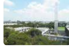
クリーンセンター新管理棟・連絡通路
