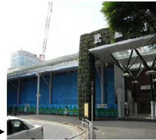
昨年完成した武蔵境駅南口駅舎連続施設 ▶
