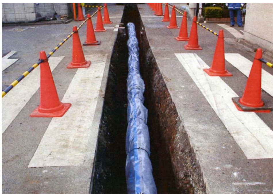
▲配水管の耐震化工事
