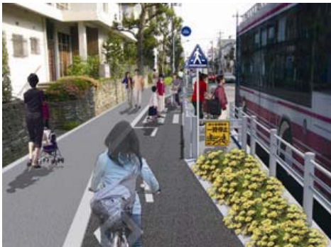
▲かえで通りイメージ図。すべり止め舗装や防護柵を施す。
