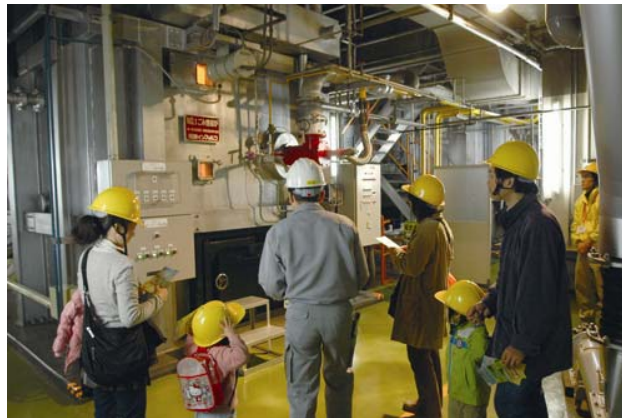
▲ 「CLEANFES むさしのエコライフ」で施設見学会を実施（平成22年11月）
