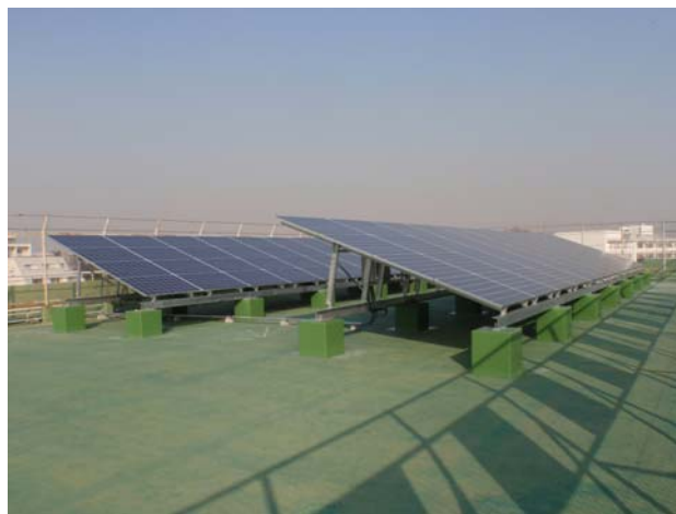
▲平成21年度に設置された第二小学校の太陽光発電設備
