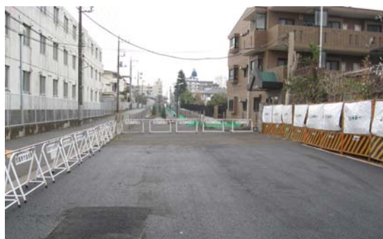
▲整備が進む市道第308号線(境南町1丁目)
