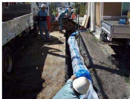
配水管の布設替え工事の様子 ▶
