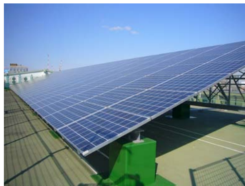
▲学校屋上の太陽光発電パネル
