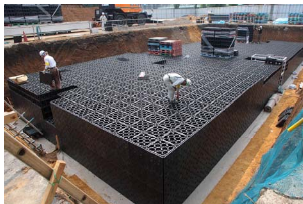
▲学校の校庭に整備される雨水貯留浸透施設
