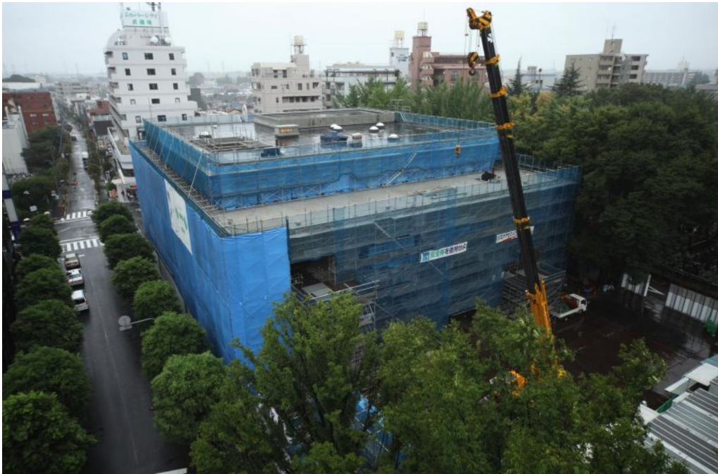
▲全景(北側より)
