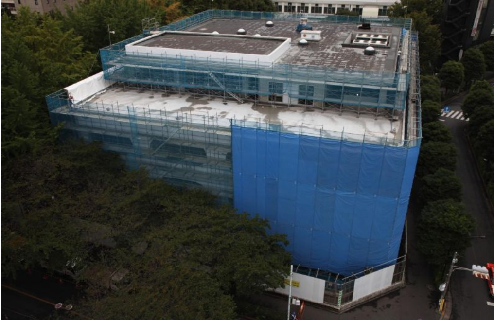
▲全景(南側より)
