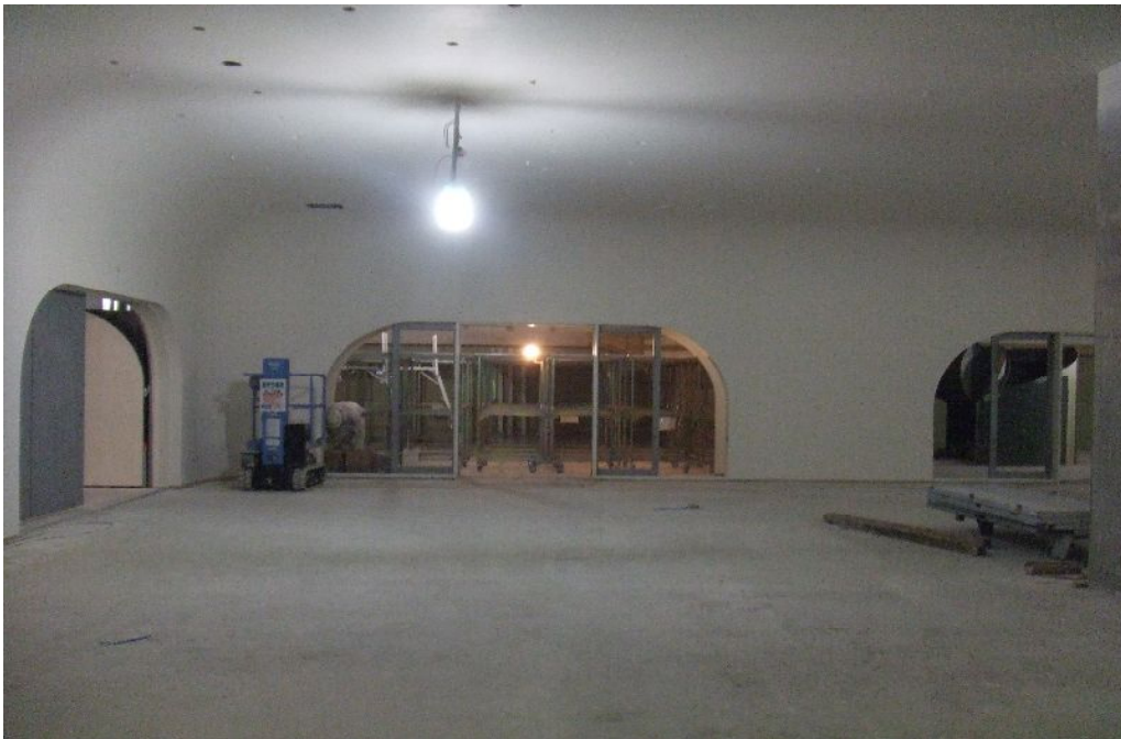
▲内装仕上工事 天井・壁 塗装工事 施工状況
