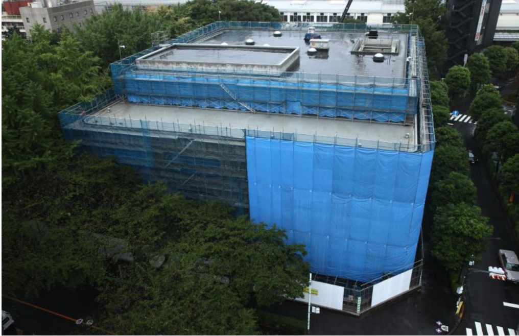
▲全景(南側より)
