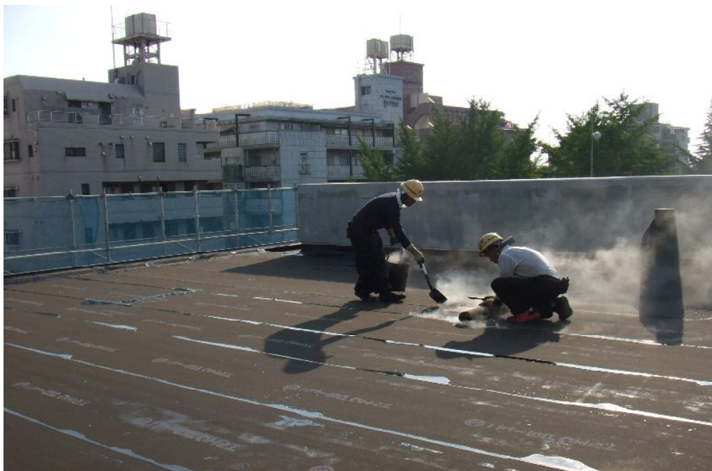
▲屋上アスファルト防水工事 施工状況
