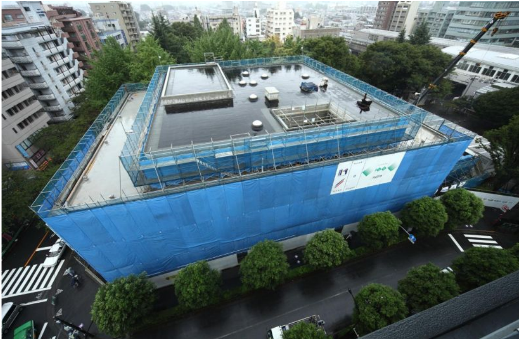
▲全景(東側より)
