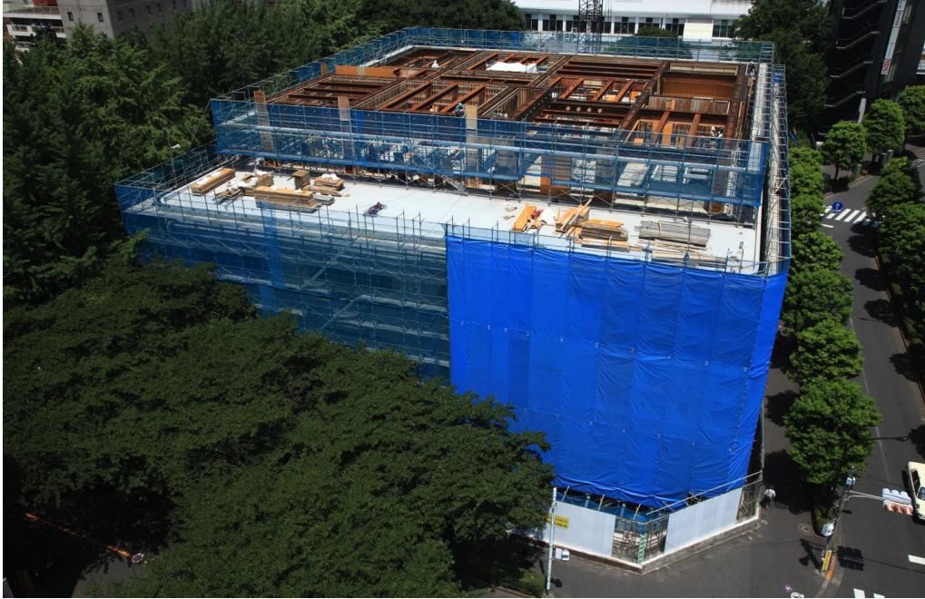
▲全景(南側より)
