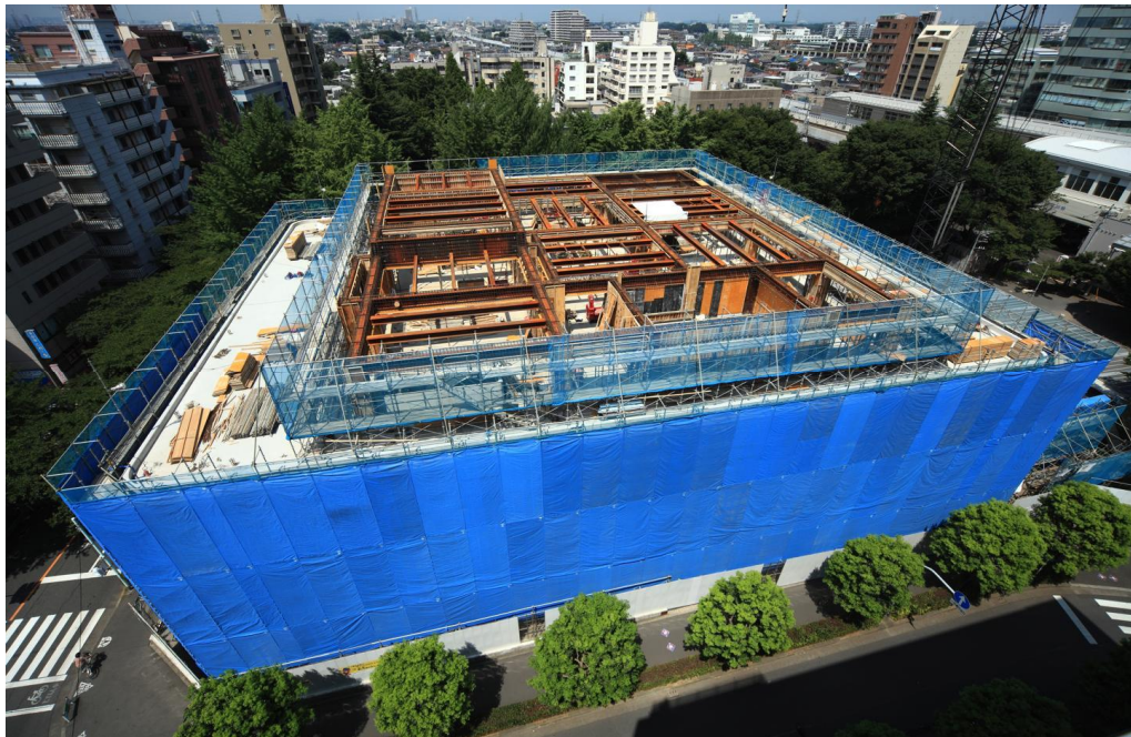
▲全景(東側より)
