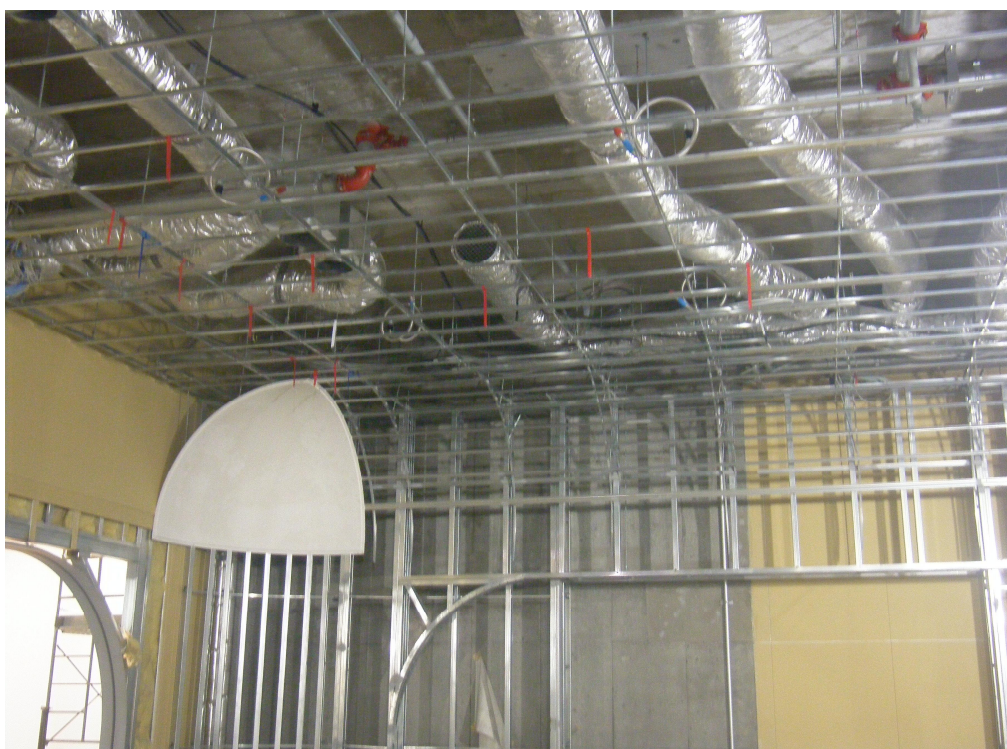
▲地下2階 内装 天井・壁軽量鉄骨組 施工状況
