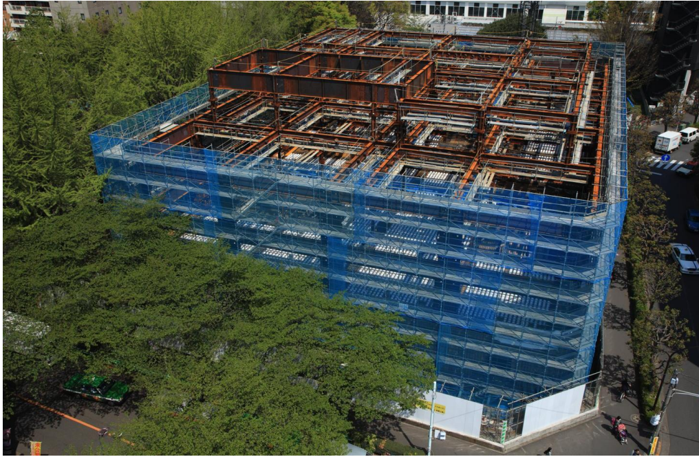
▲全景(南側より)
