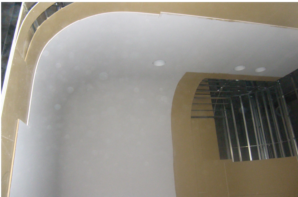
▲内装仕上げ 壁・天井 R部モックアップ
