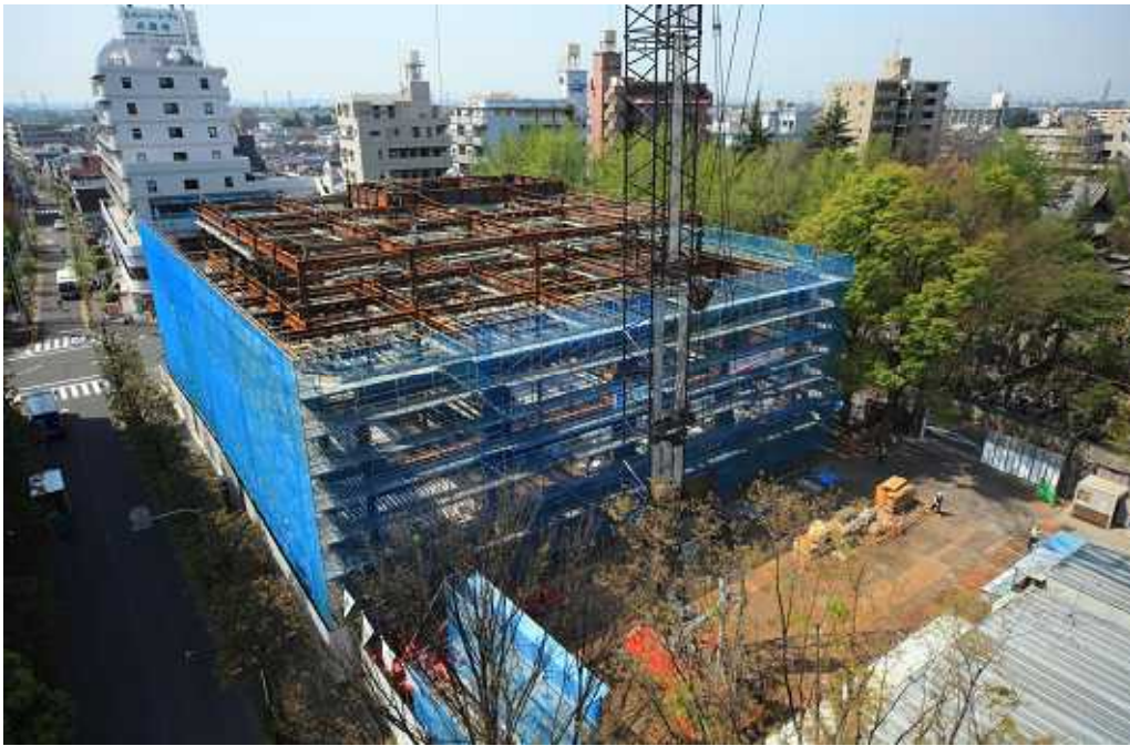
全景(北側より)
