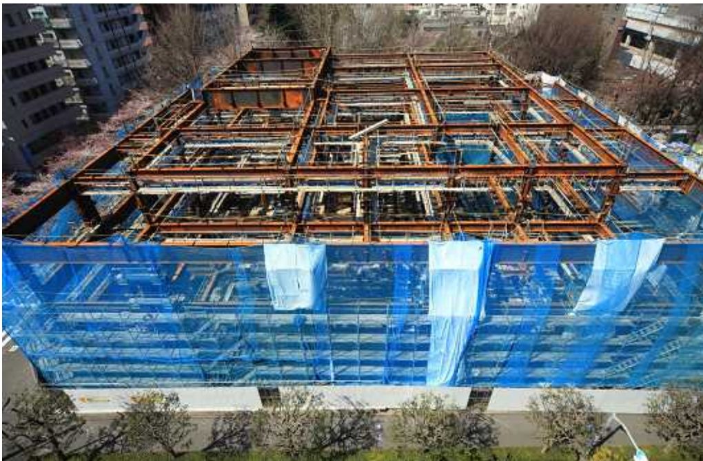
全景(東側より)
