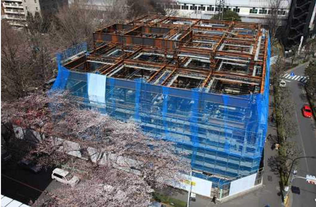
全景(南側より)
