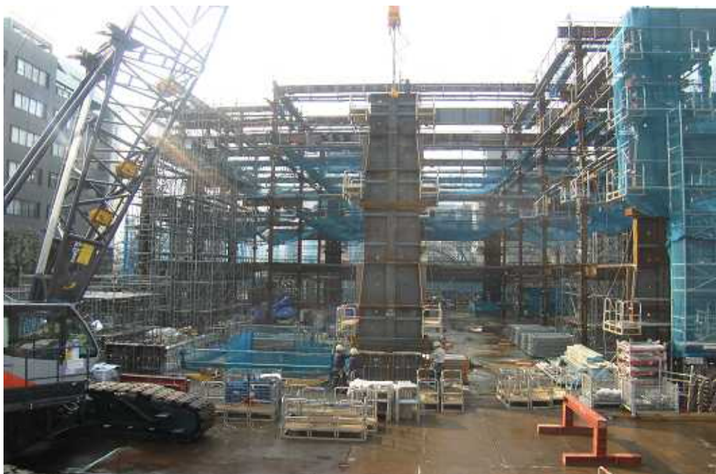
地上階 鉄骨建方状況
