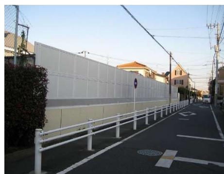
図5-5 改修後の塀の様子
