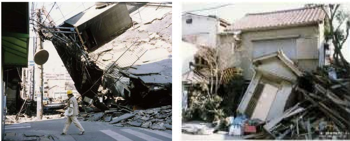
図 1 - 6 建築物の倒壊による道路閉塞の様子 (出典：左図 一般財団法人消防科学総合センター、右図 消防庁)
