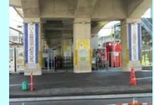
高架下駐輪場
