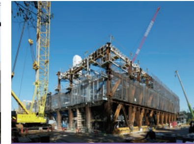
平成27年5月 地上鉄骨工事（メガトラス）
