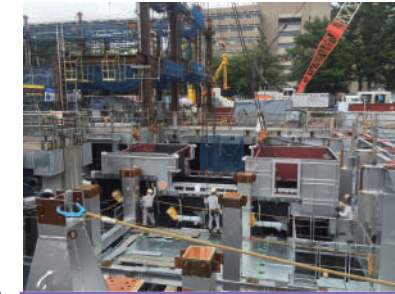
平成27年12月 プラント組み立て中の様子
