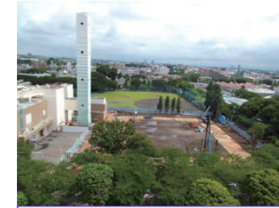
平成26年5月 工事着手
