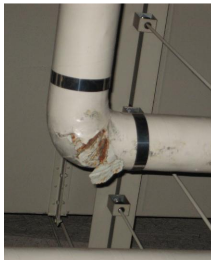
※配管に錆が発生している
