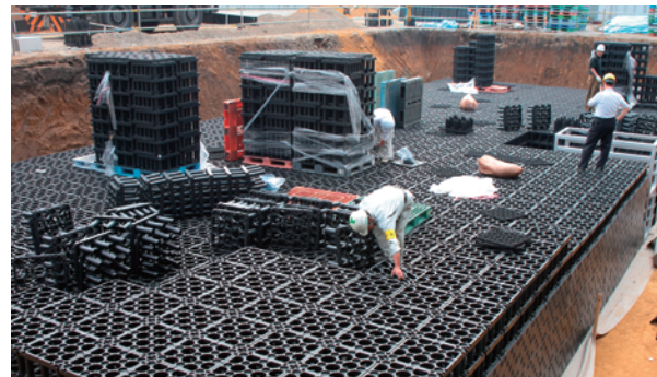
雨水貯留浸透施設
