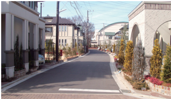
沿道部分の緑化により、良好なまちなみを形成した事例
