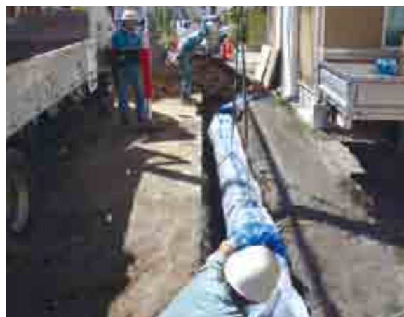
上水道耐震化工事
