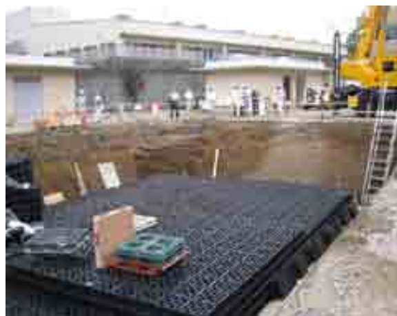
雨水貯留浸透施設の設置工事
