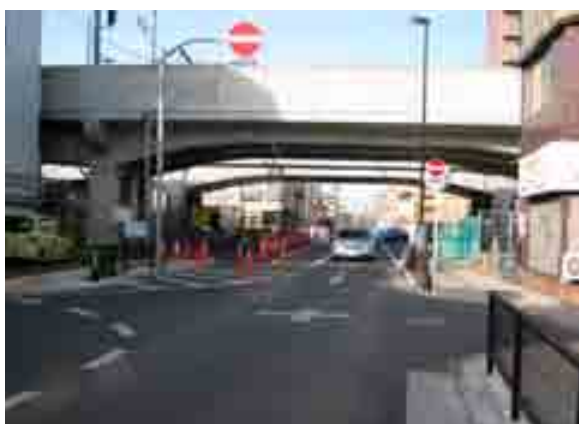
鉄道高架化（平成 21 年 12 月）により踏切が解消された武蔵境駅周辺
