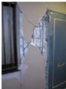
写真 5.4-27 非構造壁のせん断破壊
