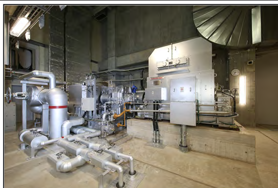
蒸気タービン発電機
