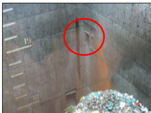
可燃ごみピットの落ち口
