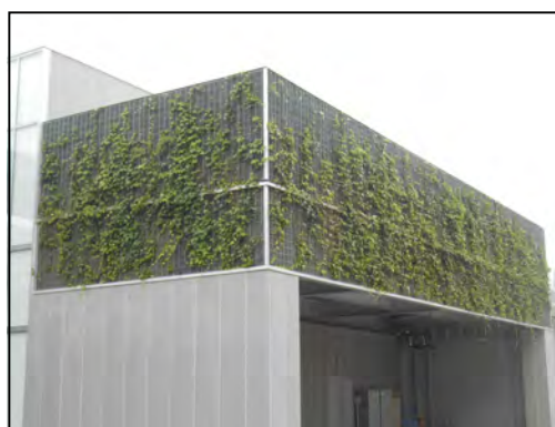
管理棟の壁面緑化
