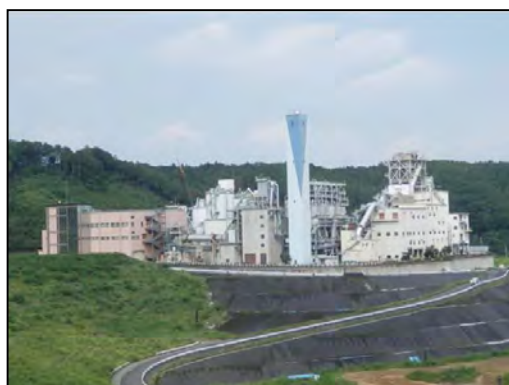
エコセメント工場全景
