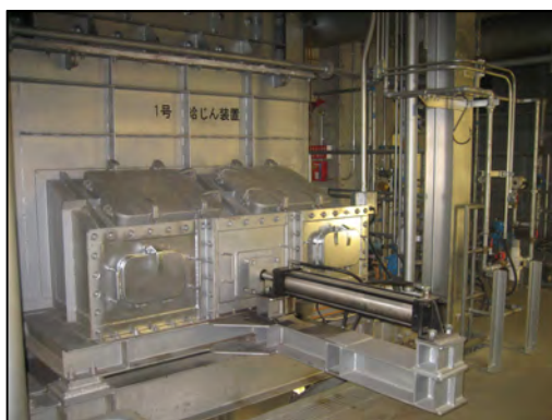
焼却炉へごみを送る給じん装置
