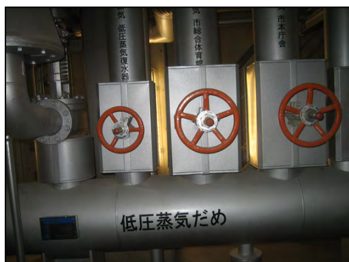
近隣施設への蒸気供給
