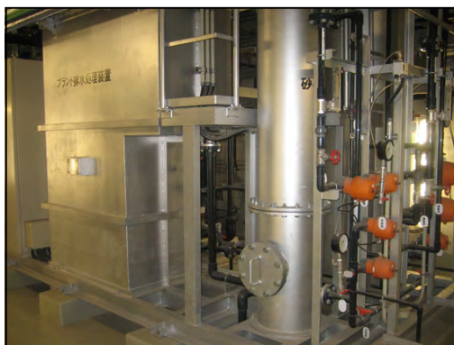
排水処理施設
