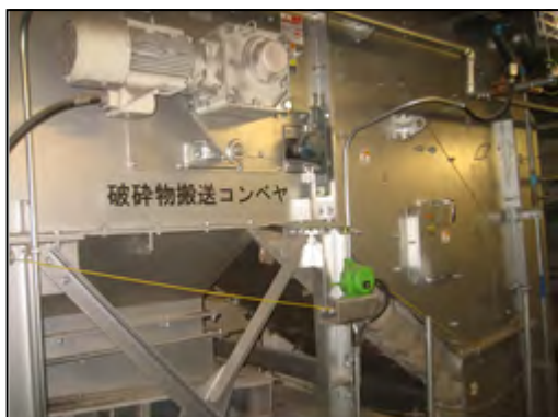
破碎物搬送コンベヤ
