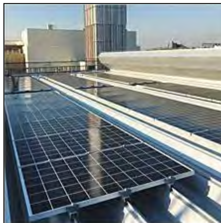
屋上の太陽光パネル（10kw）
