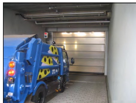
スロープ下の高速シートシャッター（閉）
