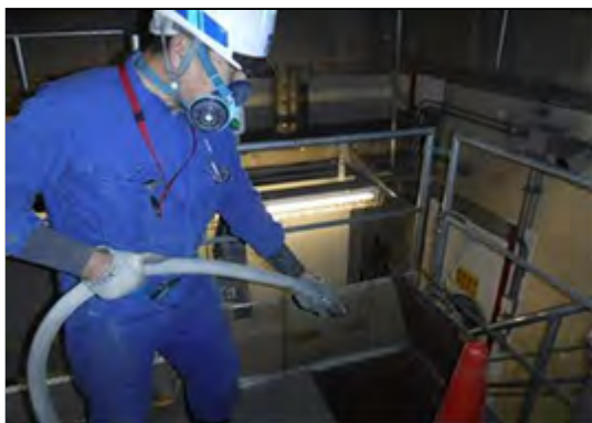
鉄ホッパーの消火訓練状況
