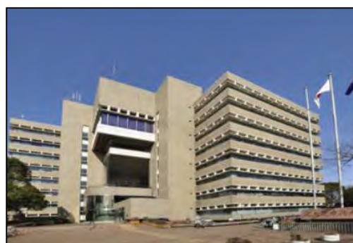
武蔵野市庁舎
