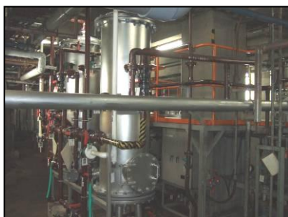
キレート樹脂塔
