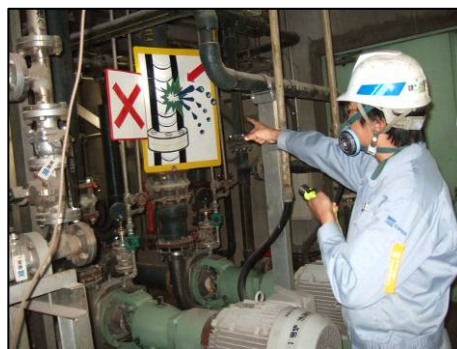
排ガス異常発生時の訓練
