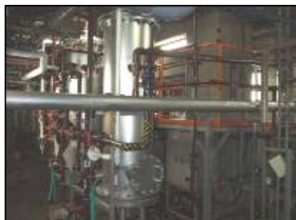
キレート樹脂塔
