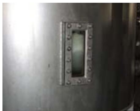
有害ガス除去装置（急冷洗浄部）
