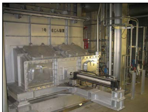
焼却炉へごみを送る給じん装置
