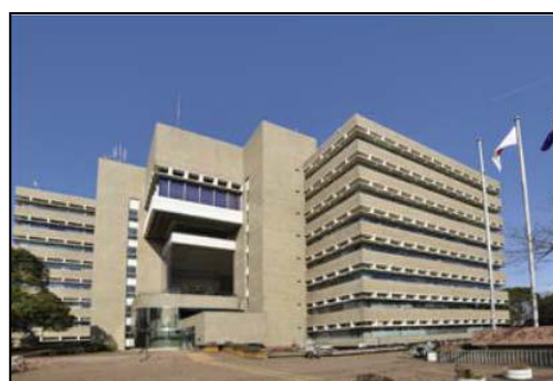
武蔵野市庁舎
