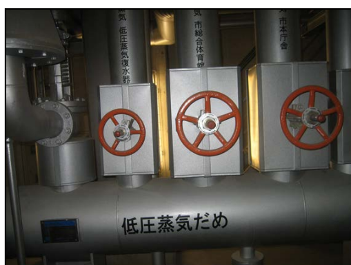
近隣施設への蒸気供給
