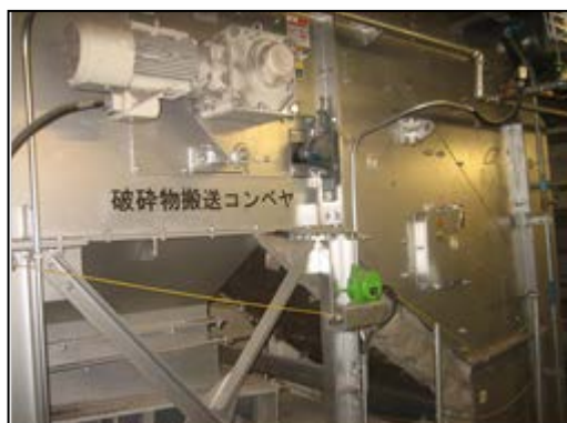
破碎物搬送コンベヤ
