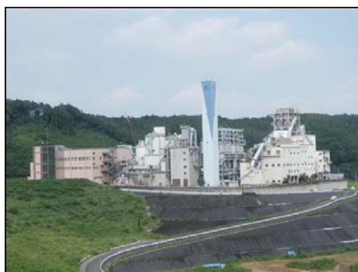
エコセメント工場全景
