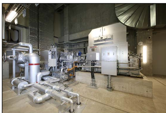
蒸気タービン発電機
