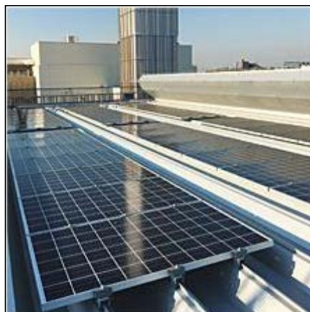
屋上の太陽光パネル（10kw）
