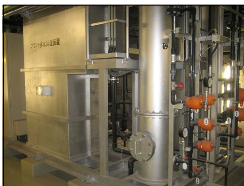
排水処理施設
