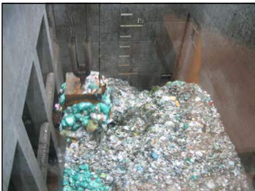
収集車のごみをおろす様子（上）、可燃ごみピットの様子（下）
