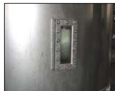
有害ガス除去装置（急冷洗浄部）
