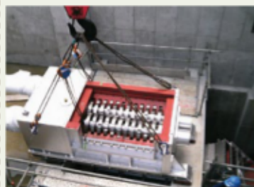
破砕機設置の様子
