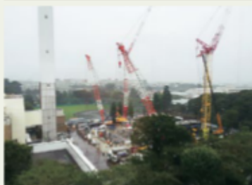
工事現場全景（武蔵野市役所屋上より撮影）
