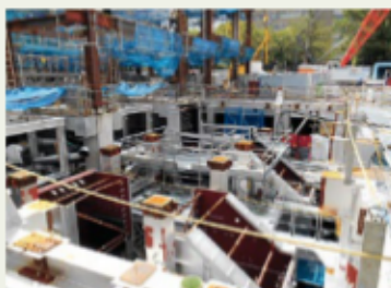
焼却炉地下部分の組み立ての様子
