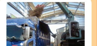
保管スペースに屋根が新設され、枝木・草葉を湿らさずに大きいトラック(10t車)への積み替え作業効率がアップ
