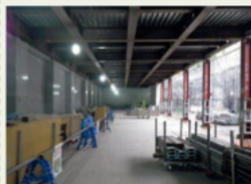
地下1階プラットフォームの様子
