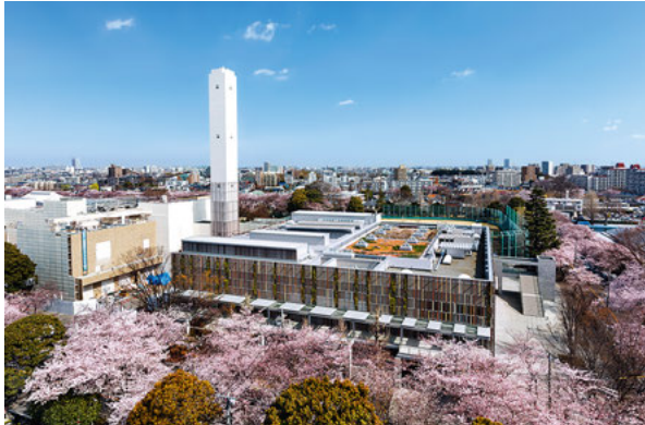
平成 29 年、新・武蔵野クリーンセンター本稼働／最新鋭の焼却・排ガス処理システムを誇る。環境学習の拠点ともなっている。
