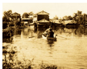
昭和33年、吉祥寺東町／第22号 狩野川台風による雨水氾濫の被害。
