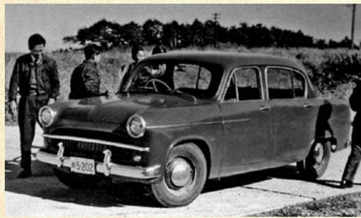
富士自動車工業（後の富士重工業）で、昭和29年に開発された「P-1」1号車。ボディには航空機技術を応用し、軽量化と耐久性が追求されている。
