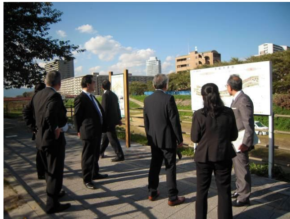
草津川跡地整備工事現場
